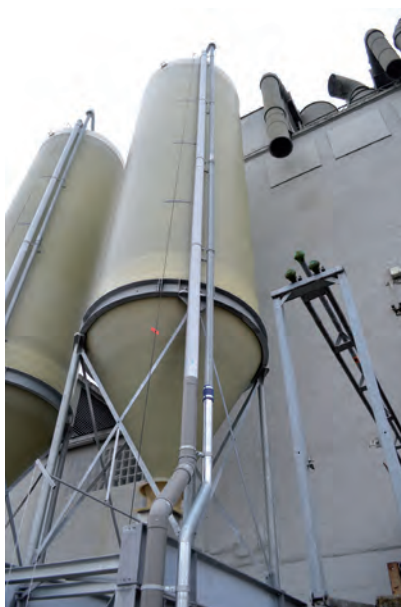
Silos für Streusalz, Schüttgüter etc. im Außenbereich aus der „monolithischen“ GFK-Reihe
